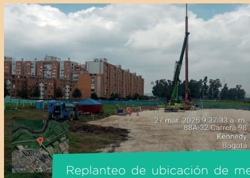
Replanteo de ubicación de mechas drenantes, maquinaria y equipo para instalación
