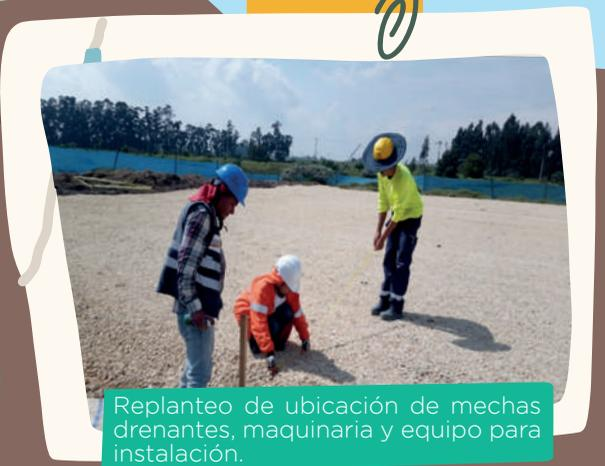
Replanteo de ubicación de mechas drenantes, maquinaria y equipo para instalación.
