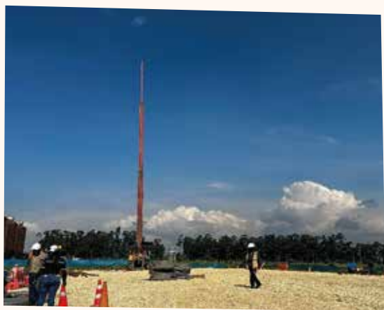
Replanteo de ubicación de mechas drenantes, maquinaria y equipo para instalación
