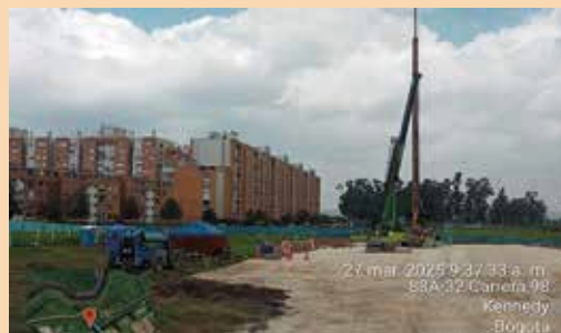
Replanteo de ubicación de mechas drenantes, maquinaria y equipo para instalación
